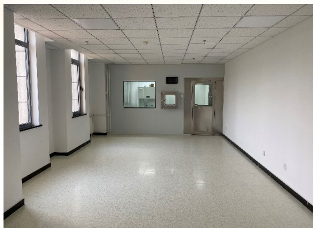
图2 13号楼C1实验室超净间建设 (2021.08.31)
